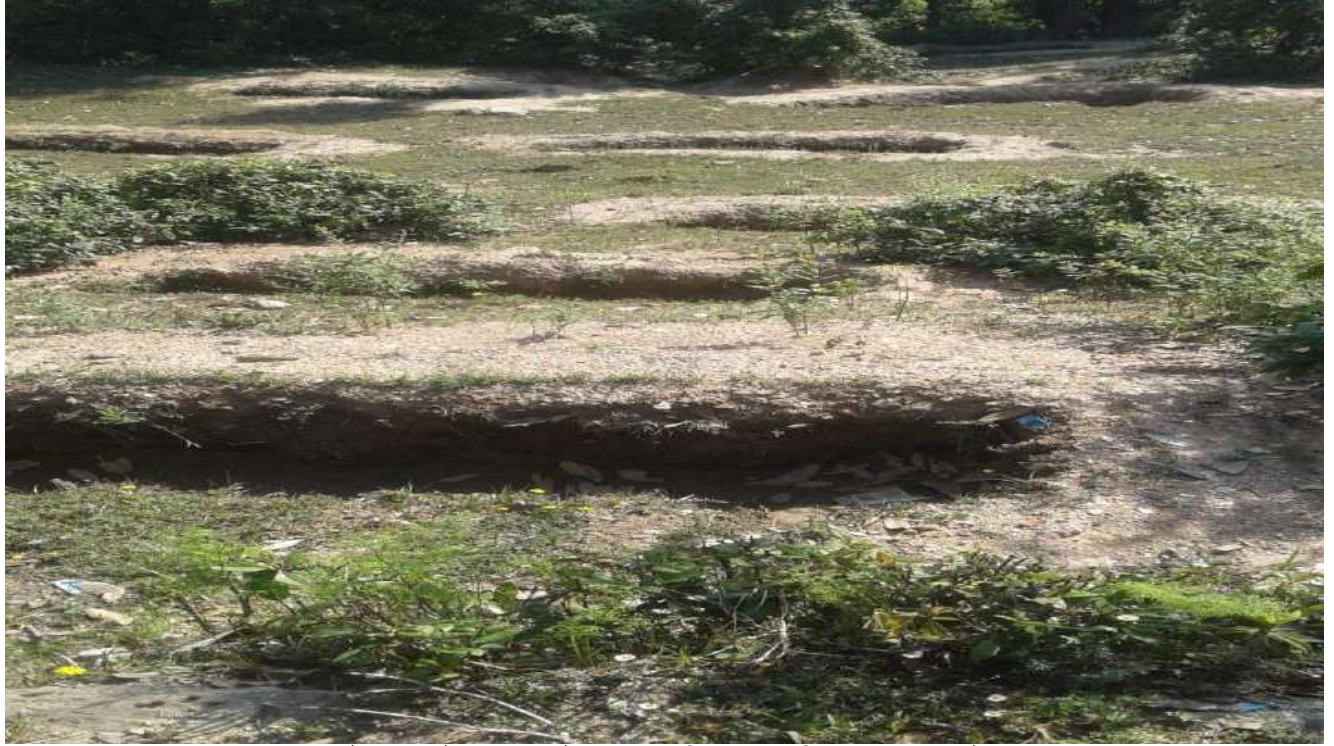
मनरेगा योजना के अन्तर्गत निर्मित कन्टूर ट्रेन्च
